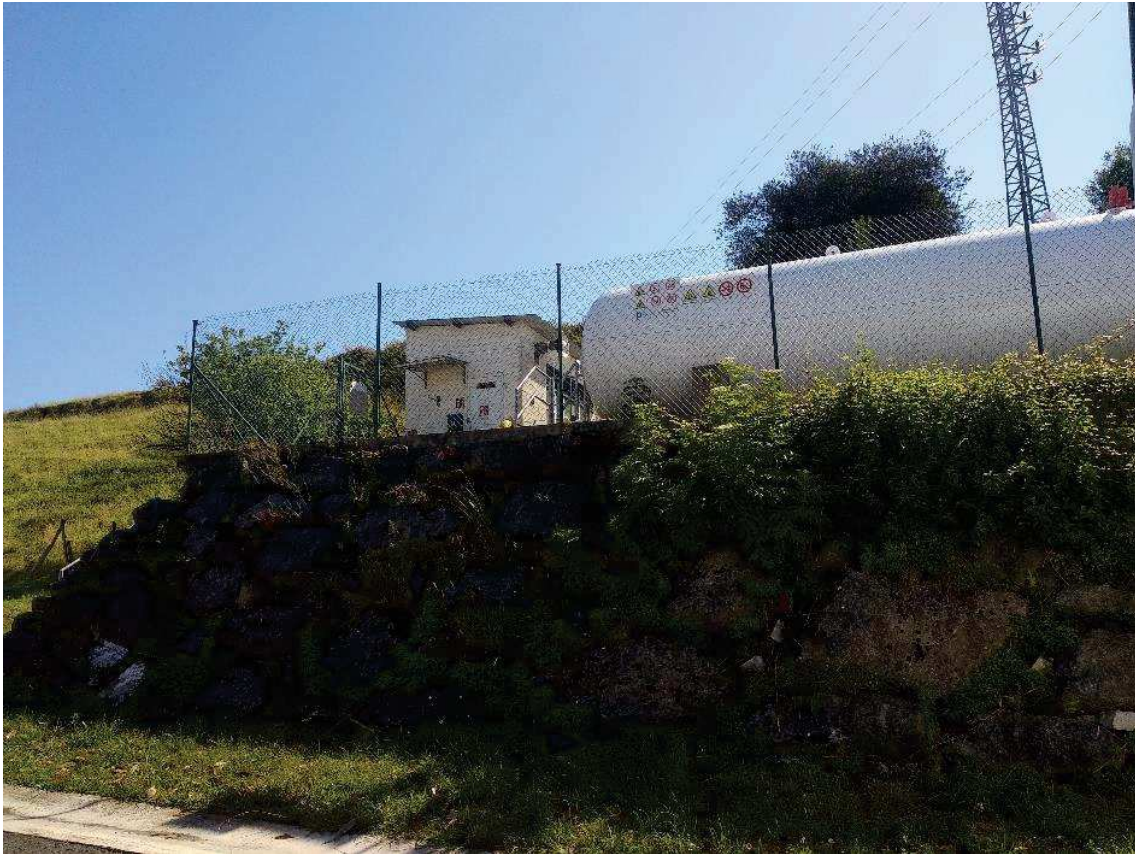
Depósito de gas natural en el polígono industrial y junto el talud existente.
