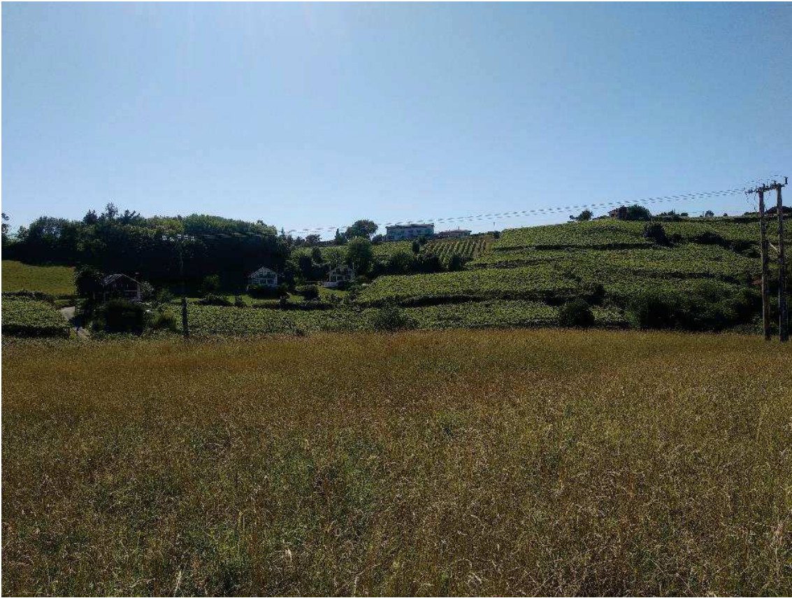
Dos torres de tendido eléctrico de hormigón.
